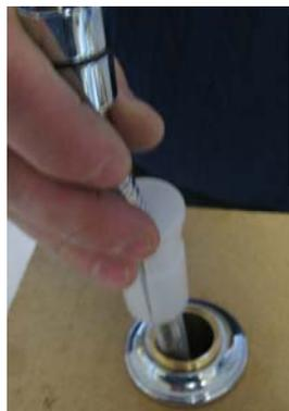
10) Descendre la pièce plastique dans le coulant sans engager l'écrou conique du flexible.
