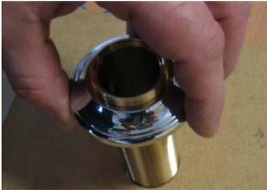
5) Positionner le coulant dans le trou diam 35 prévu sur la plage de baignoire.
