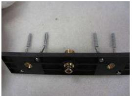
Fixer la plaque support à l'aide des 4 vis fournis, les chevilles fournies sont pour un mur plein, pour une cloison sèche veuillez utiliser les chevilles adéquat. Visser ensuite les deux pièces en inox support du bec.
